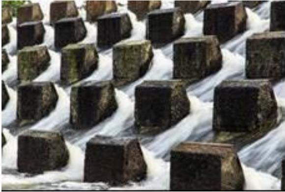
*Figure 30 ralentisseur de courant Source : MEC Mining 2014*
