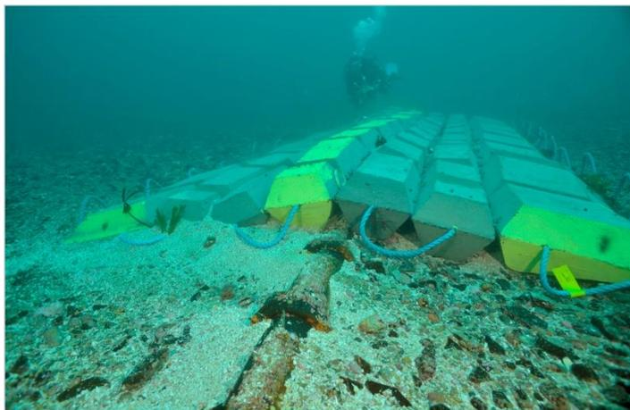
*Figure 24 Matelas et tube de protection*
