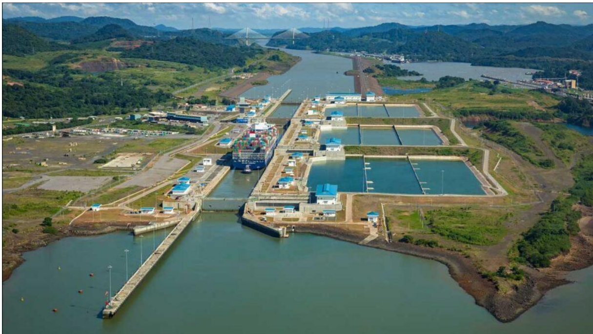
Figuur 20 Neo-Panamaxsluizen aan de Stille Oceaan met aan de rechterkant de recuperatie bassins
