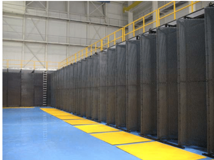
Figuur 46 Verticale absorbeerder Bron: Klinghammer et al. (2012)
