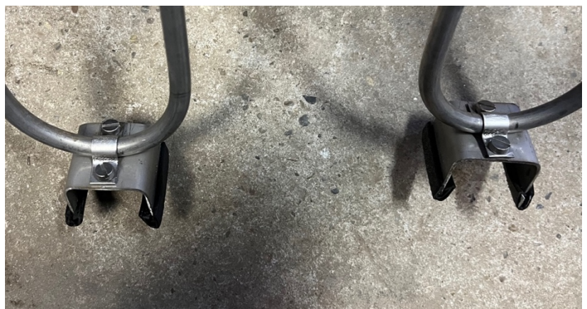
Figuur 4: voetjes elektrische weerstanden
