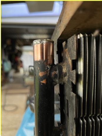
Figuur 3: reparatie lek waterkoeler
