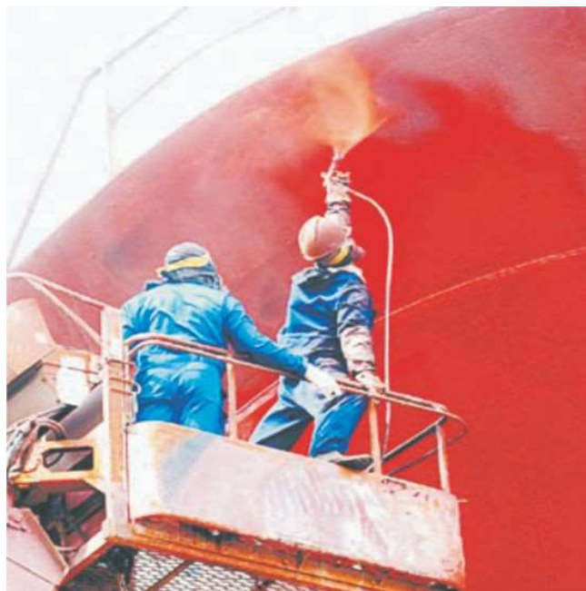
Figuur 14. Gebruik van een airless spray systeem met overspray (Made in China, 2024).
