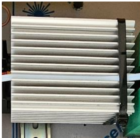
Figuur 6: De luchtbuis die rust in de warmtezone van de Rittal-kastverwarming
