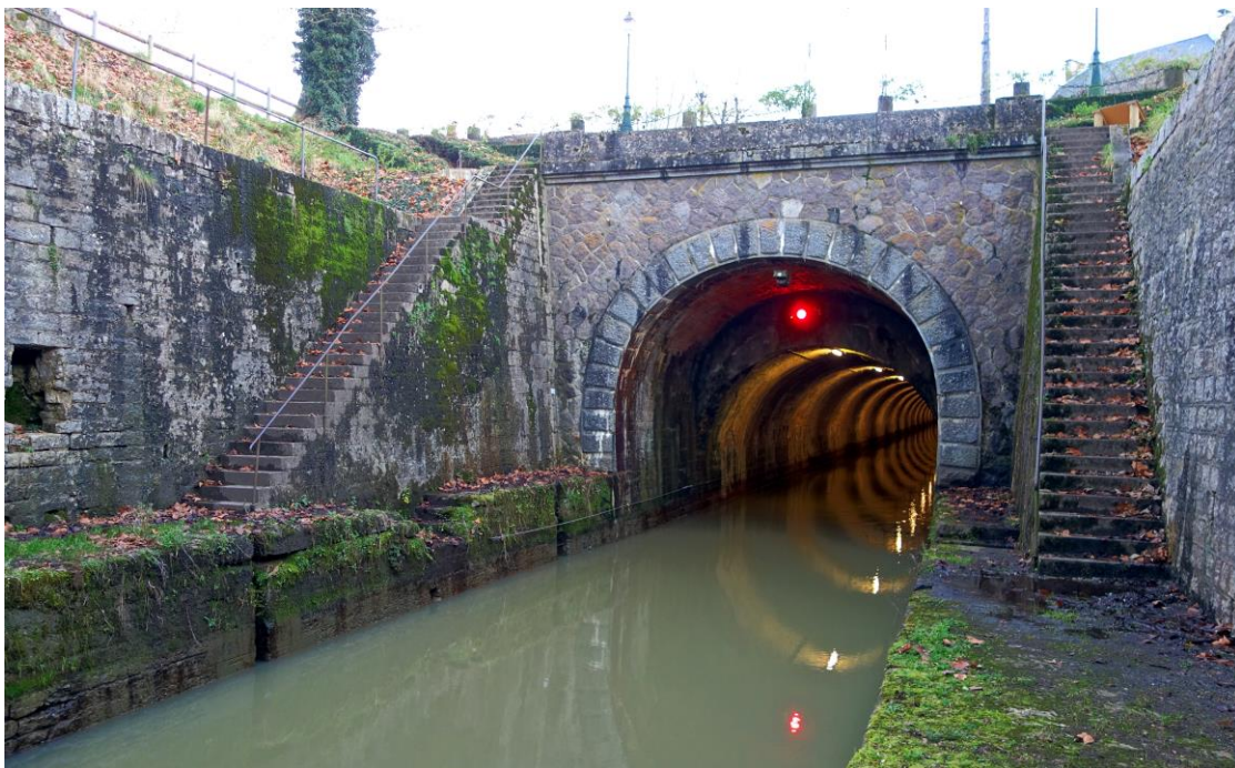
Figure 38 - Le Tunnel de Pouilly-en-Auxois
