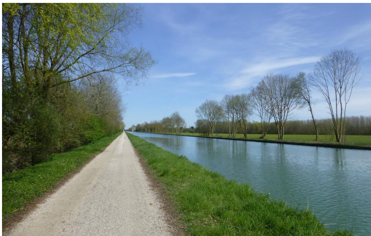
Figure 39 - Canal de Saint-Quentin
