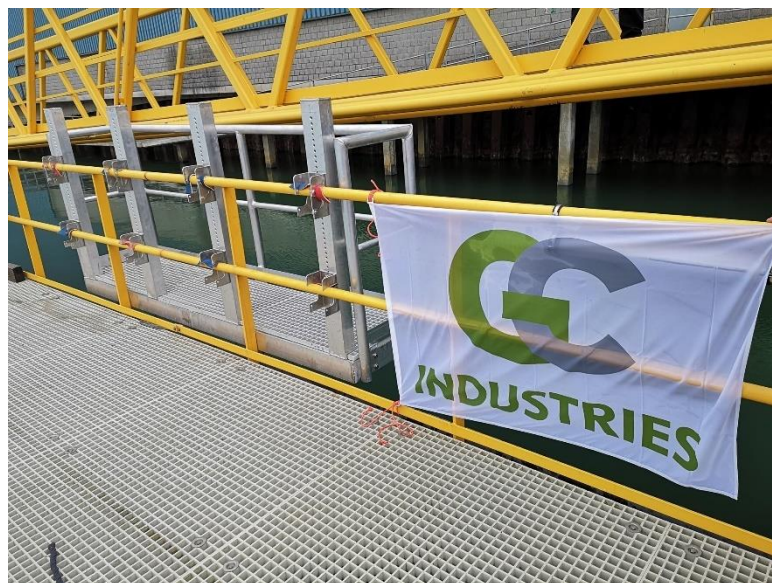
Figuur 24: Het platform op het ponton
