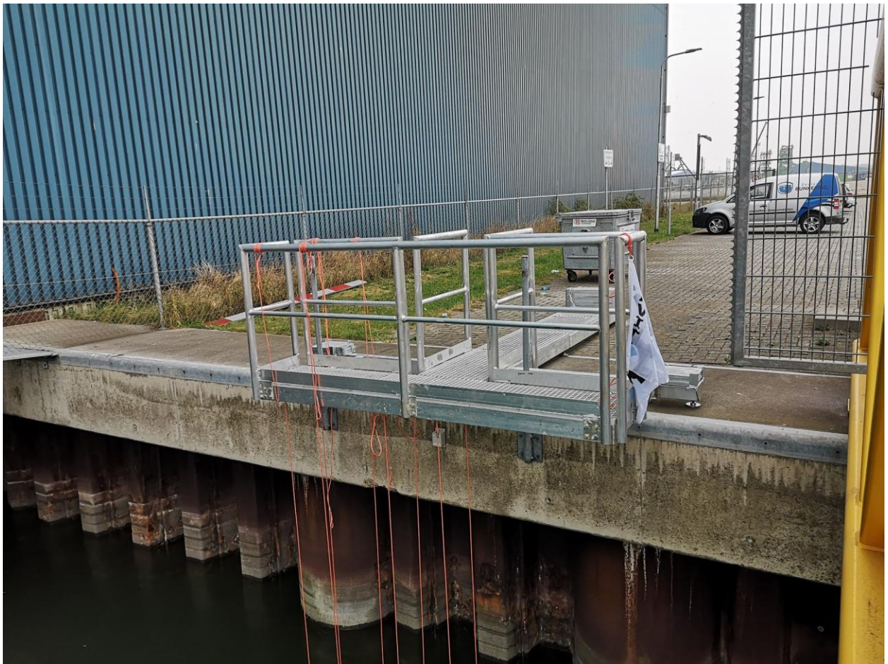
Figuur 22: Vooraanzicht van het platform op de kaai na installatie
