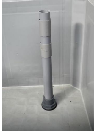
Figuur 12: Vaste overloop
