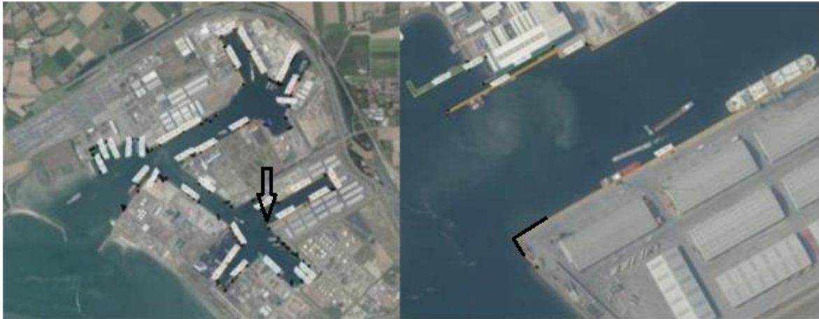
Figuur 16 Locatie kademuur VK0101
