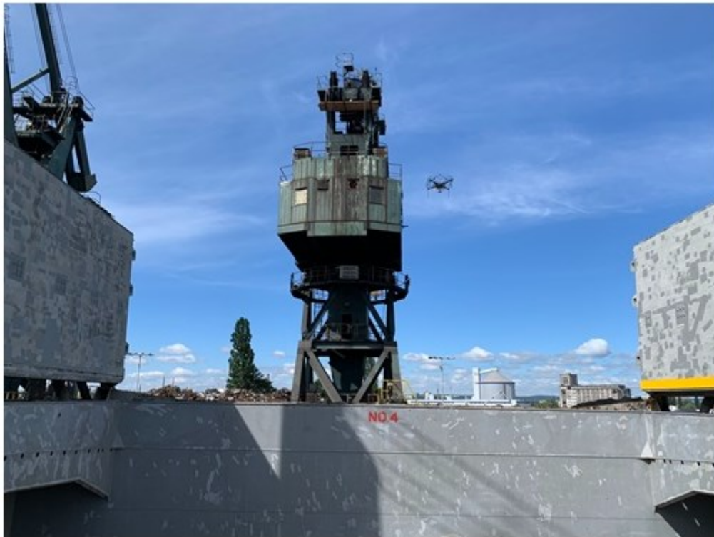
Figure 13 Audit effectué par RINA à l'aide d'un drone pour une certification intermédiaire
