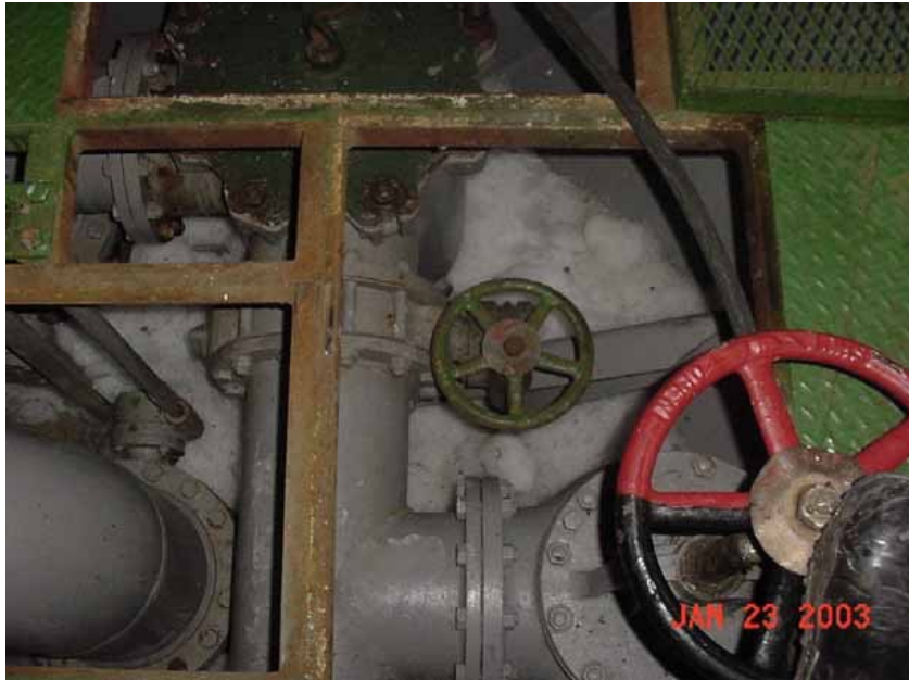
Figure 25 : Accumulation de glace dans le fond de la machine
