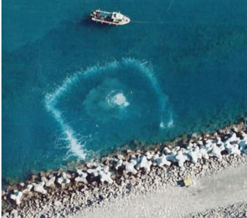
Figuur 6 Het bovenaanzicht van een bubble barrier
