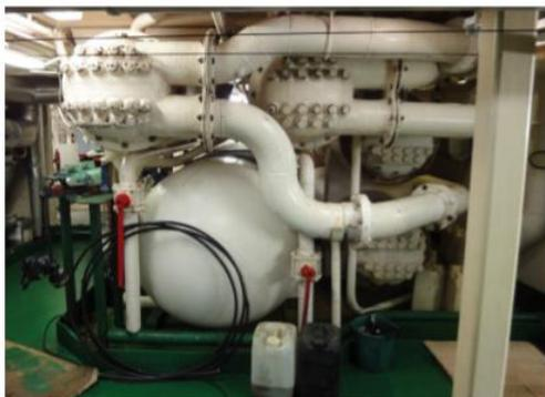
(c) Les condenseurs (en haut), le receveur (dessous) et les deux brinechiller (à droite)
