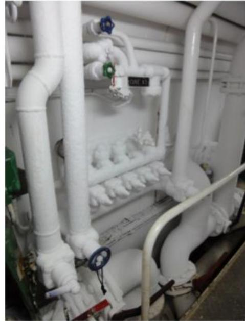
(b) Une station de vannes d'une cuve : en haut les 3 vannes liquides, au milieu les régleurs, en bas les vannes de retour
